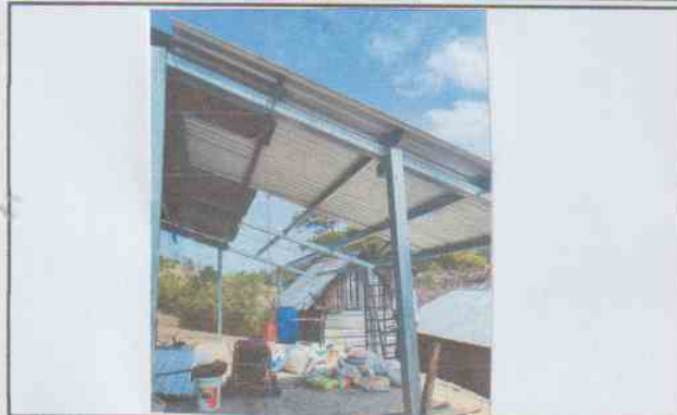
Foto 1: Estructura de techo.
