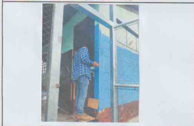
Foto 3: Pintura en muro interior y exterior.
